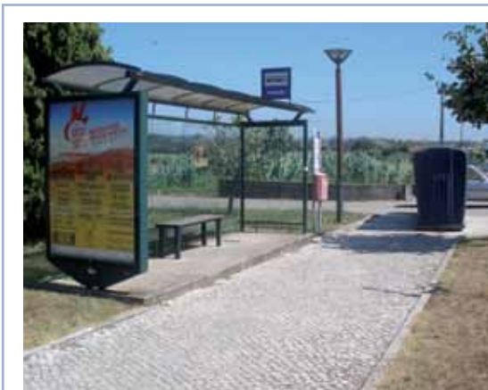
Figura 125: Acesso a abrigo inacessível.
