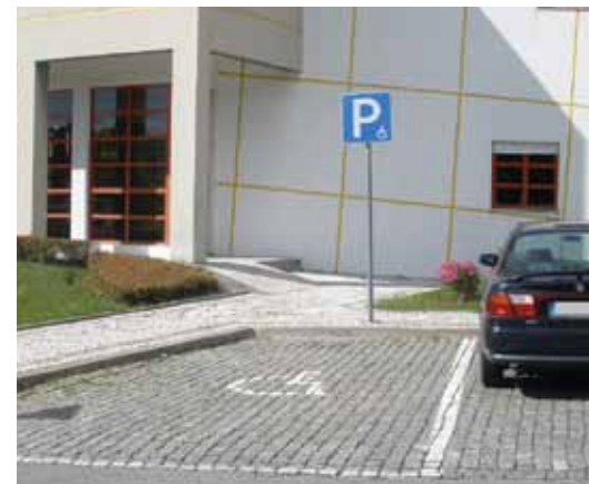
Figura 79: Estacionamento não regulamentar.
