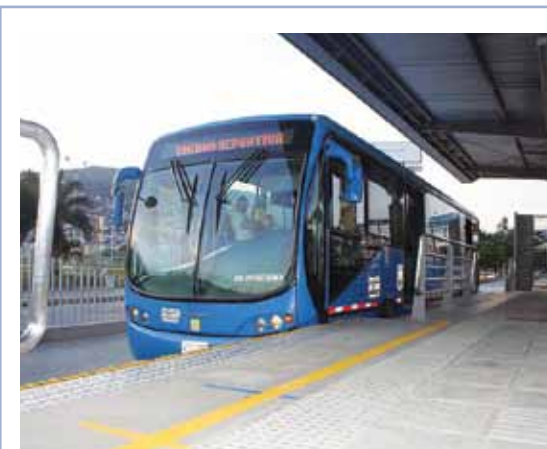
Figura 133: Pisos diferenciados em plataformas de embarque.
