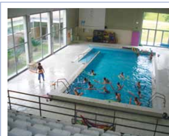
Figura 108: Acesso ao tanque não regulamentar (má configuração dos corrimãos).
