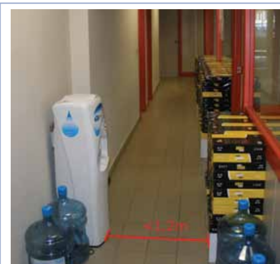
Figura 95: Corredor não regulamentar.
