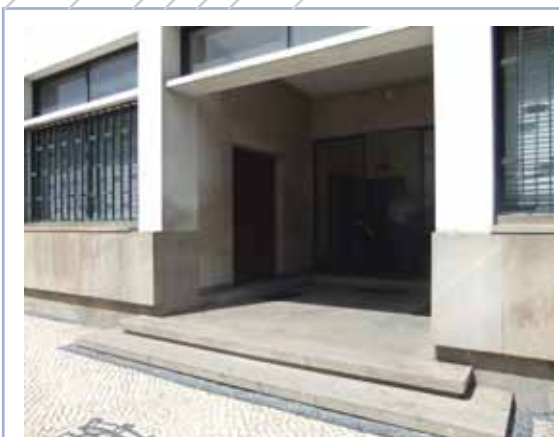
Figura 84: Entrada não acessível.
