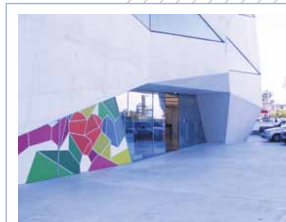
Figura 92: Porta acessível (automática).
